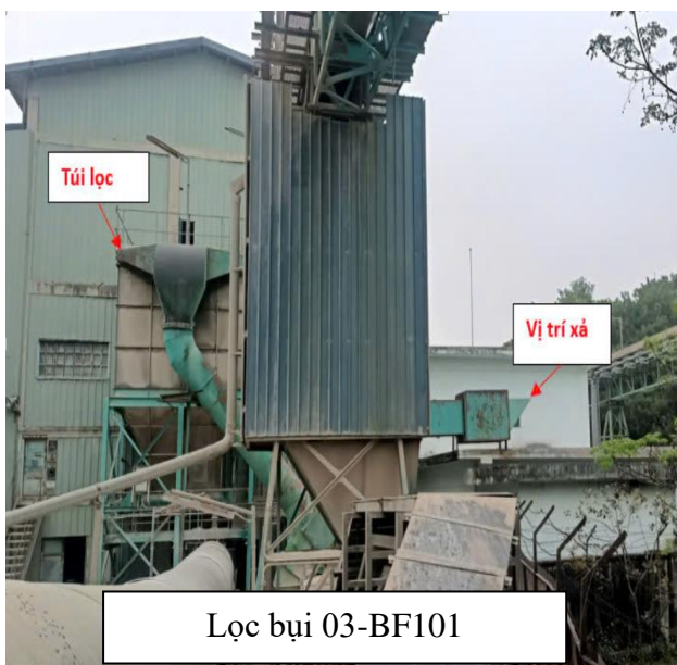
Hình 3.15. Hình ảnh Hệ thống lọc bụi túi vải tại Mỏ đá
