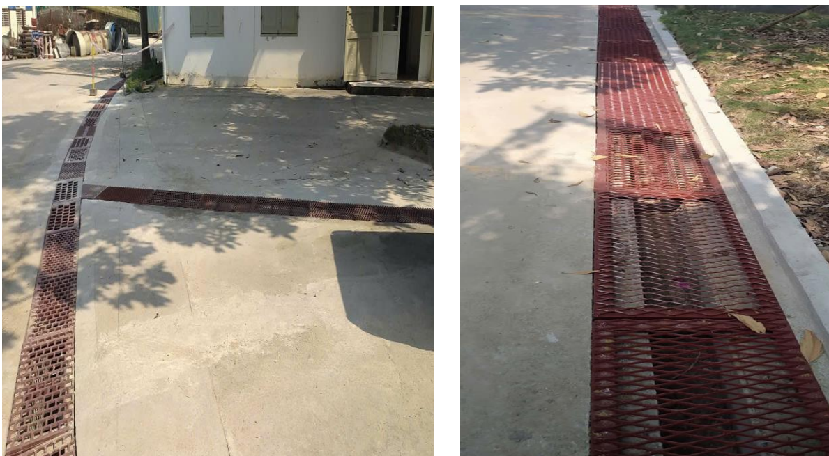
Hình 3.2. Hiện trạng tuyến mương thoát nước mưa của mỏ đá
