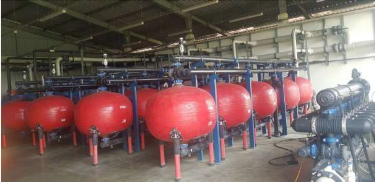
Hình 1. 8. Hệ thống lọc cát
