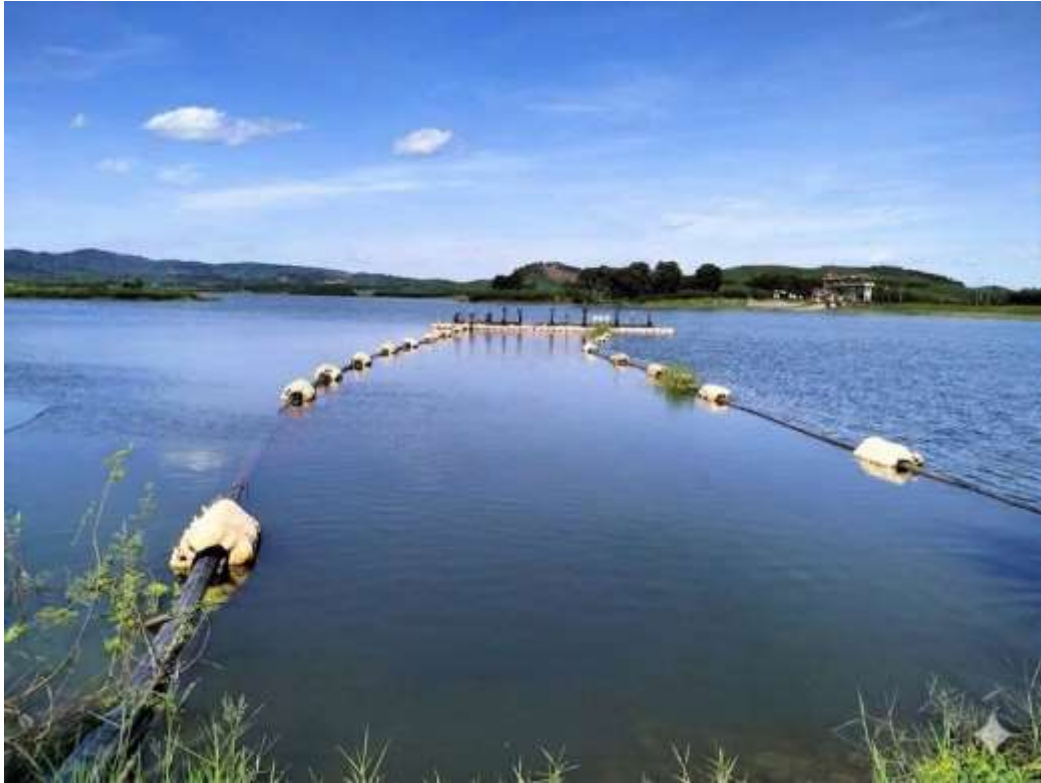
Hình 1. 6. Hệ thống bơm cấp nước ngoài sông
