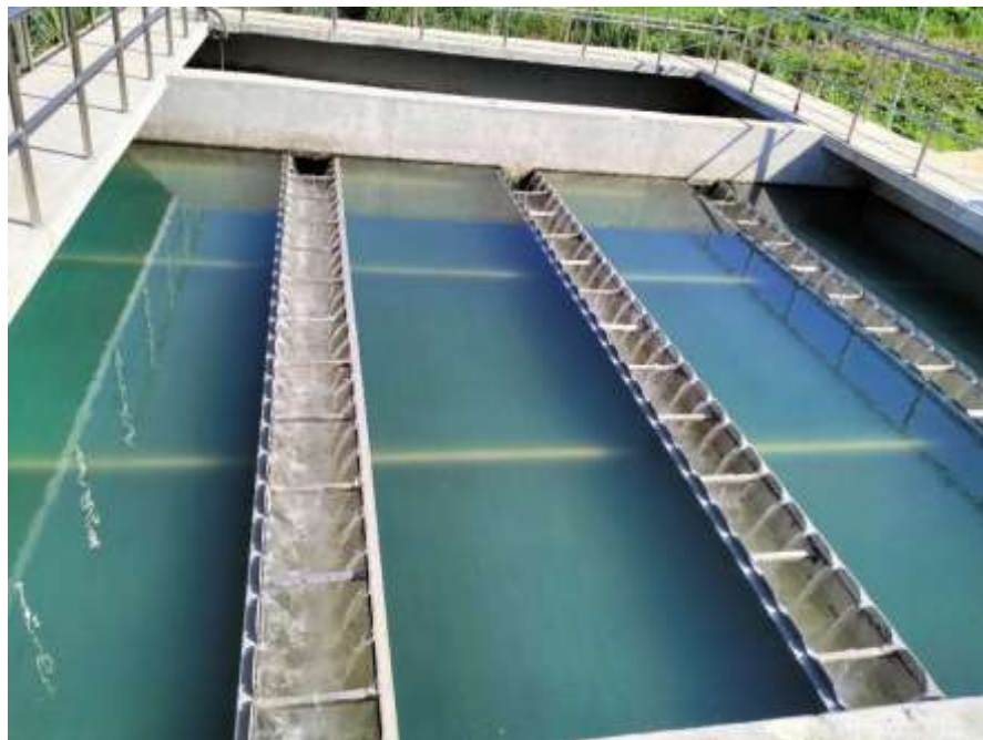
Hình 1. 7. Hệ thống lắng Lamella
