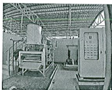
Hệ thống xử lý nước thải tập trung công suất 495 m 3 /ngày.đêm Hình 9. Một số hình ảnh HTXLNT đã xây dựng tại Nhà máy
