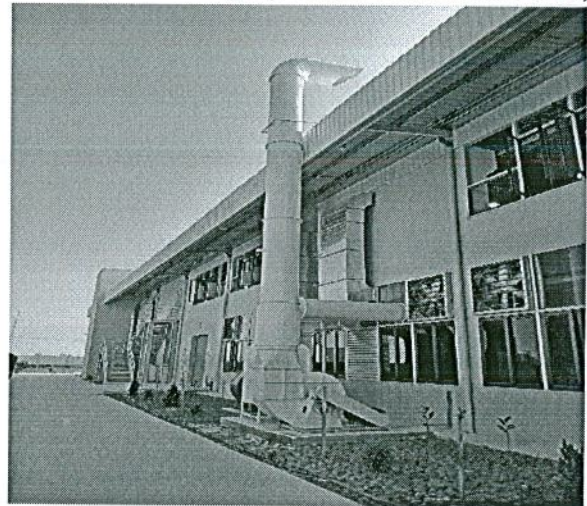
Hình 16. Hệ thống xử lý khí thải hơi dung môi từ khu vực quét keo-chiều xạ
