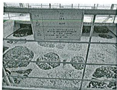
Hệ thống xử lý nước thải tập trung công suất 495 m 3 /ngày.đêm Hình 9. Một số hình ảnh HTXLNT đã xây dựng tại Nhà máy
