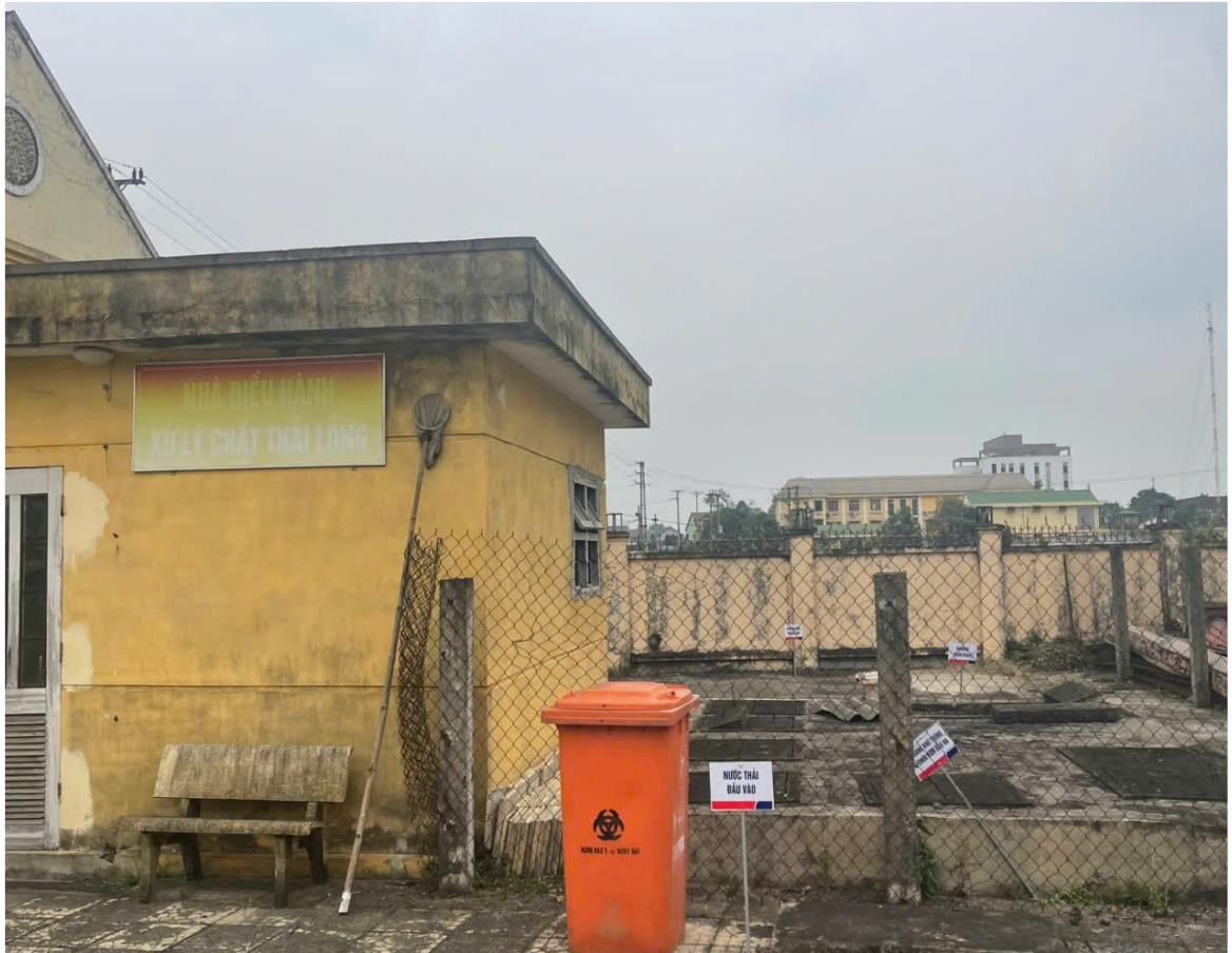
Hình 3. 7. Hệ thống bể ngầm khu xử lý nước thải của Trung tâm
