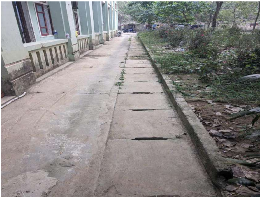
Hình 3.2. Hệ thống mương thu thoát nước mưa tại cơ sở
