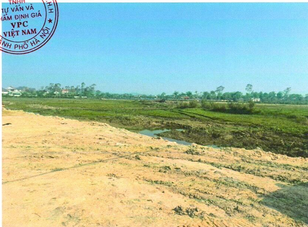
Hình 1: Hiện trạng Khu đất thực hiện dự án Khu nhà ở tại phường Cửa Lò, tỉnh Nghệ An
