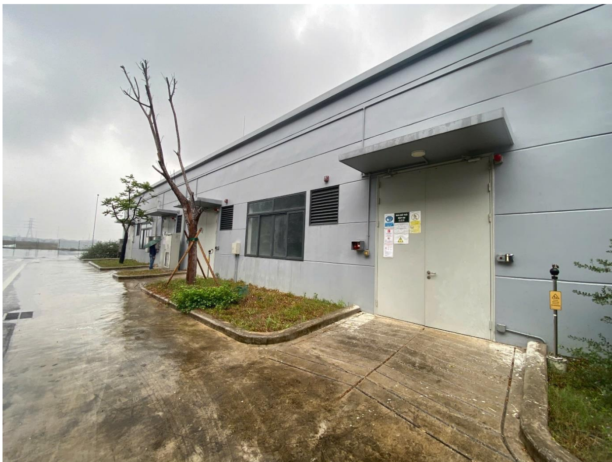
Hình 20: Khu vực lưu chứa chất thải rắn thông thường của dự án
