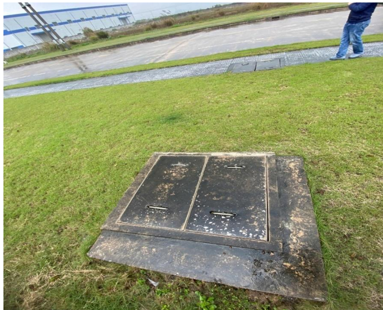
Hình 7: Điểm đầu nối nước mưa của dự án
