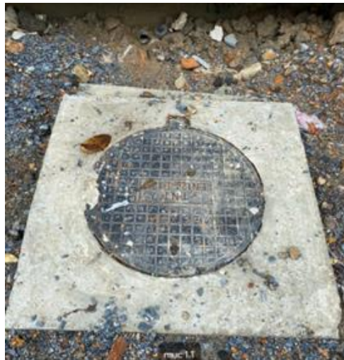
Hình 3.2. Hố ga thu gom nước mưa tại Nhà máy
