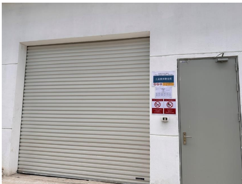
Hình 3.21. Kho chứa chất thải rắn công nghiệp thông thường tại nhà máy
