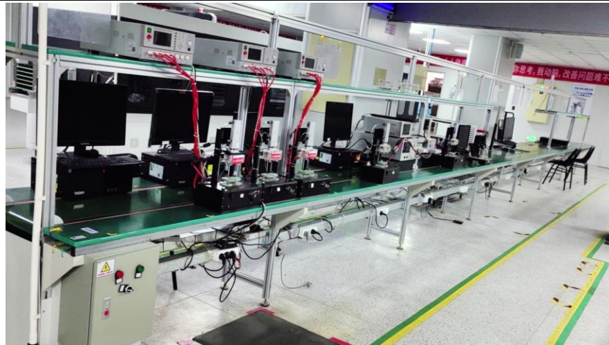
Hình 1.15. Khu vực nhà xưởng bố trí dây chuyền sản xuất cuộn cảm
