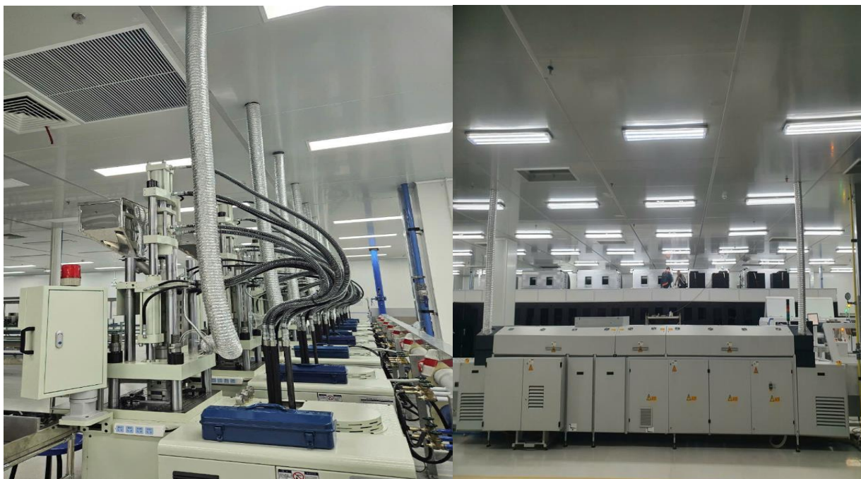
Hình 3.16. Hình ảnh các thiết bị thu gom khí thải tại nhà máy
