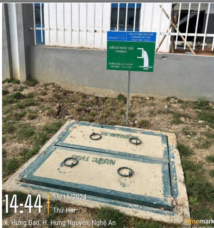
Hình 3.7. Hình ảnh điểm đầu nối nước thải của dự án
