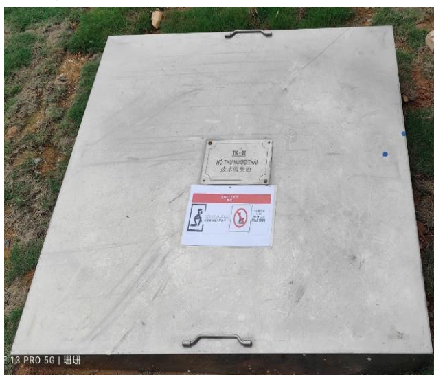
Bể thu gom
