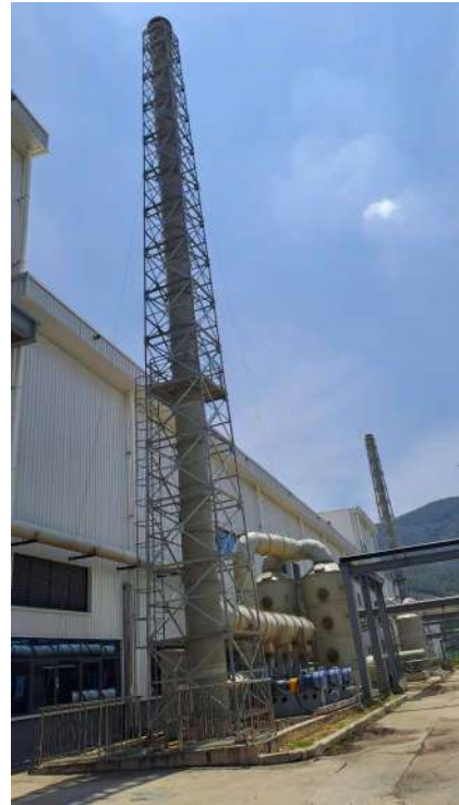
Hệ thống xử lý bụi Silic dạng lọc bụi kiểu ướt số 1 và số 2, công suất 26.000 m 3 /h/hệ thống
