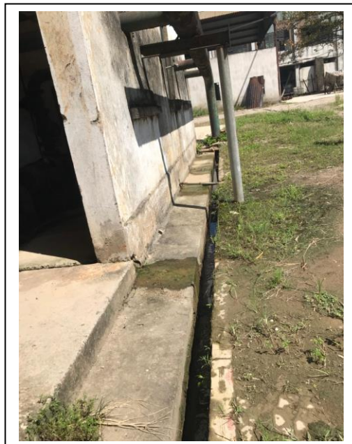
Hình 3: Mương thoát nước mưa nội bộ nhà máy
